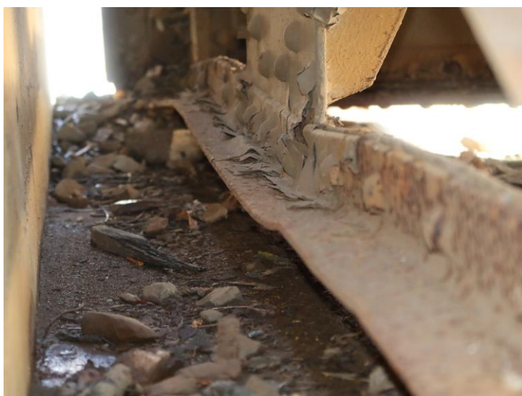
Foto č. 1 Konstrukce K 01 – 1. příčka – deformace
